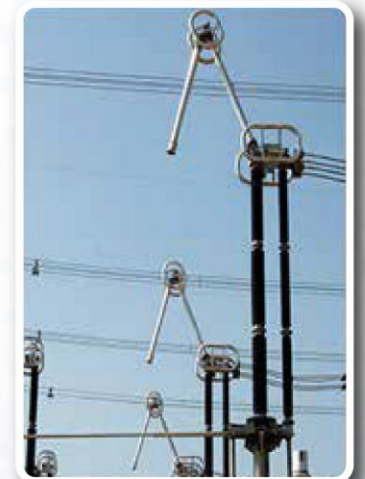
Seccionador Tipo Rodilla OPP hasta 1220 kV.
