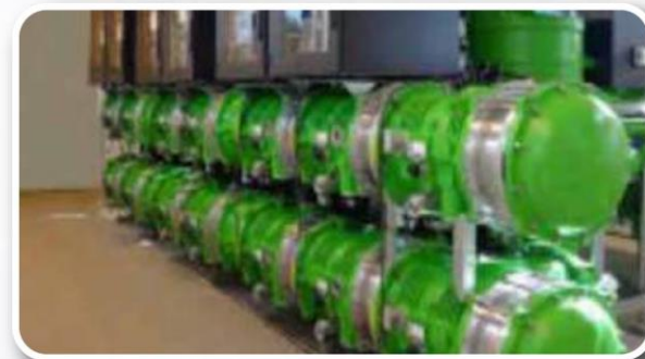
Subestación GIS B105 hasta 245 KV, 50 KA. y 3150 A
