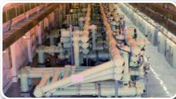
Subestación GIS B105 hasta 245 KV, 50 KA. y 3150 A
