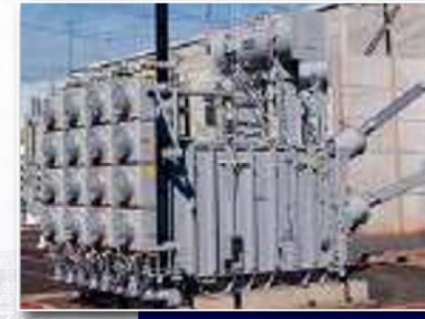
Transformadores HVDC convertidores hasta 500 MVA
