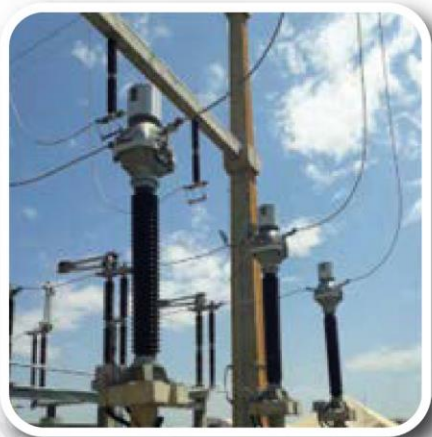
Transformador de corriente (TC) en aceite OSKF hasta 800 KV.
