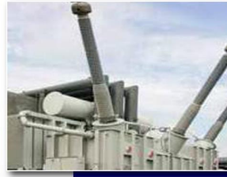
Transformador de potencia convencional
