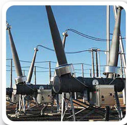
Int. de tanque muerto hasta 550 KV.
