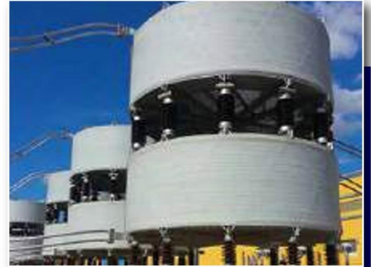
Reactor de núcleo de aire (ACR) para alta tensión
