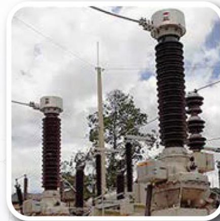
Transformador de tensión (TT) en aceite OTEF hasta 420 KV.
