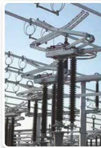
Seccionador lateral doble S2DA hasta 550 kV.
